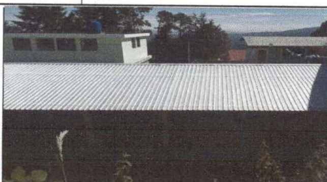
Foto 2: Instalación de capote para lámina troquelada aluzinc
