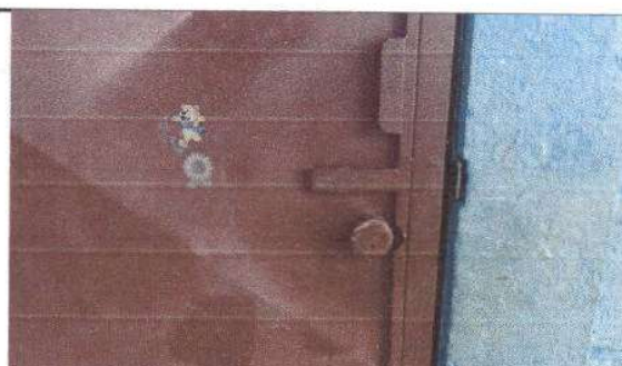
Foto 6: Sustitución de chapa marca Yale en una puerta de un aula
