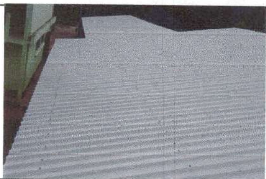
Foto 3: Sustitución de elementos de fijación (tornillos)
