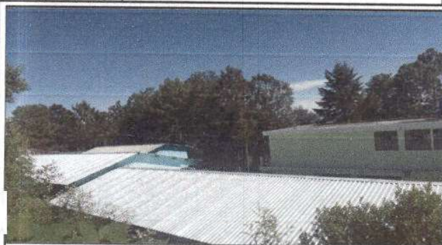
Foto 1: Instalación de lámina troquelada aluzinc c 26 (0.40 mm=)
